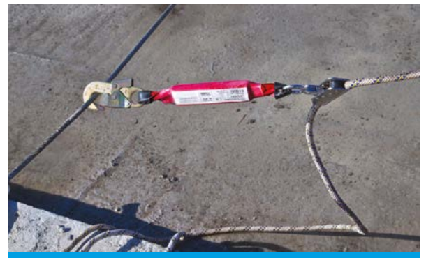
Kotwienie do prowadnicy liniowej stosowanej zgodnie z zaleceniami producenta.
