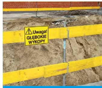
Zabezpieczenie krawędzi wykopu.
