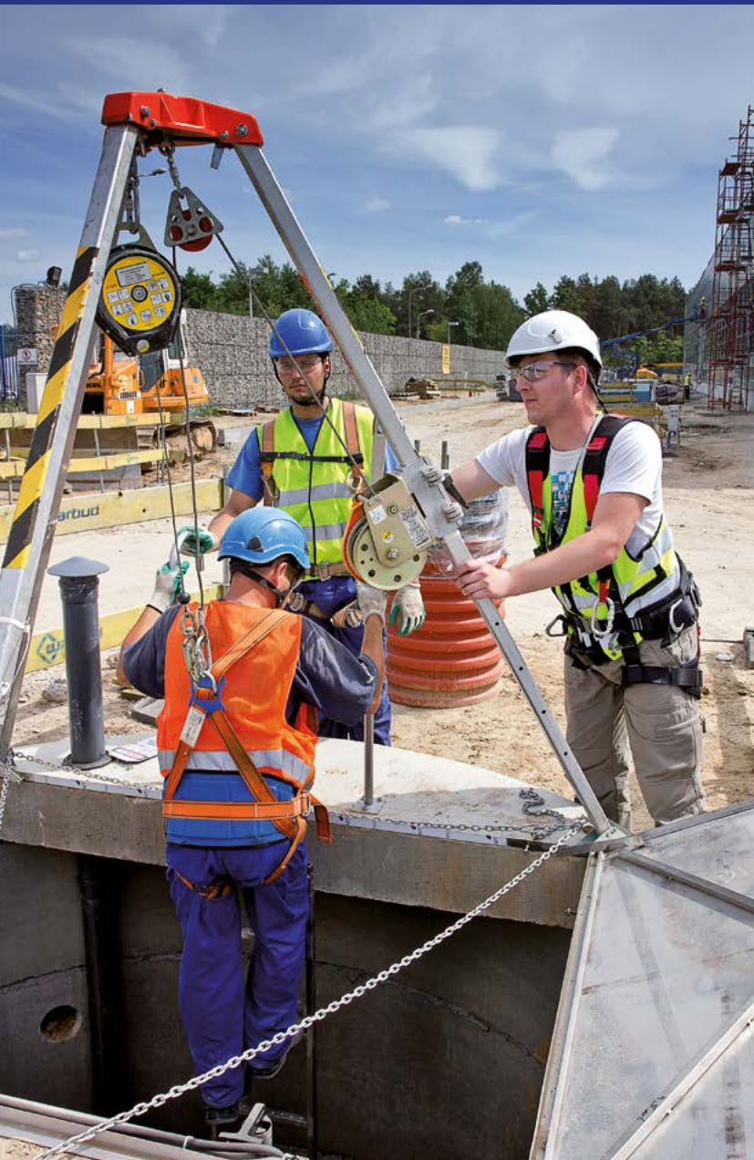
Urządzenie umożliwiające ewakuację nieprzytomnego pracownika.
