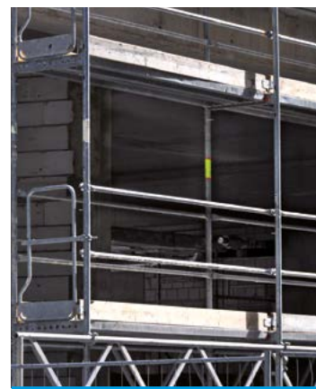
Balustrady ochronne od szczytu rusztowania.
