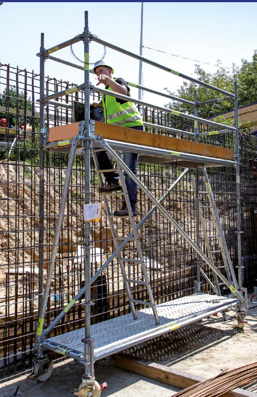
Hamulec rusztowania przejezdnego.
